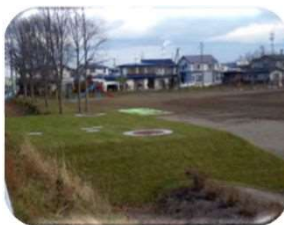
応急給水拠点（緊急貯水槽等）
