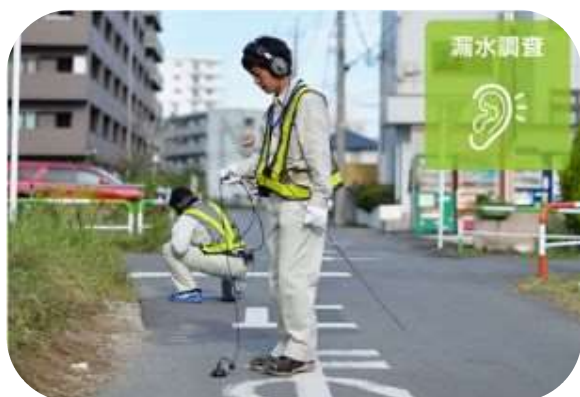
漏水探知機による調査
