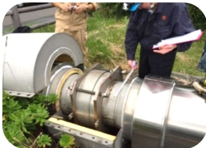
管路の点検作業の様子
