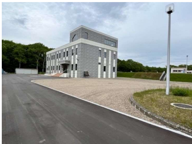
高丘浄水場（場内整備完了）
