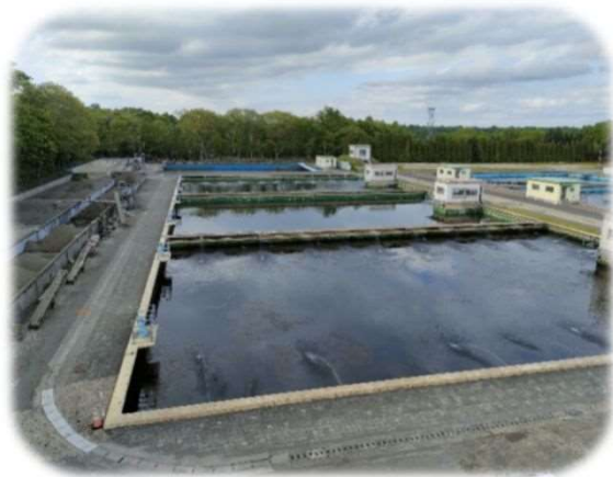
1～3号緩速ろ過池
