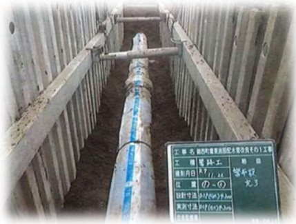
配水管改良工事
