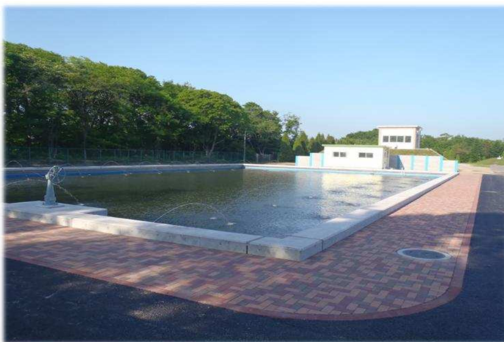
高丘浄水場7号緩速ろ過池
