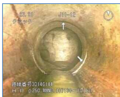
既設管渠の状況(カメラ調査結果)
