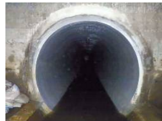
更生工法による更新（更新後）
