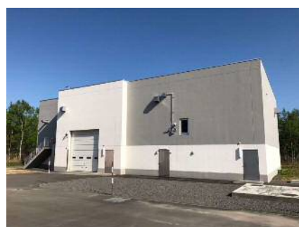
沼ノ端中継ポンプ場
