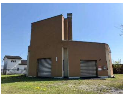
錦岡中継ポンプ場
