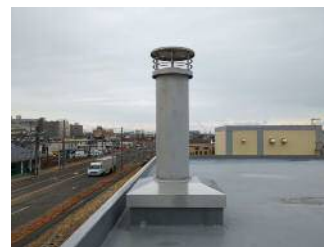
管理本館煙突（更新後）
