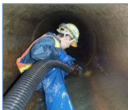
管渠清掃作業の様子(管内)
