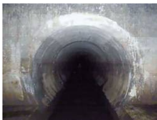
老朽管の状況（更新前）
