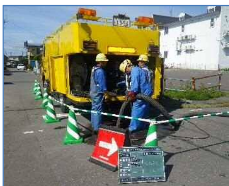
管渠清掃作業の様子
