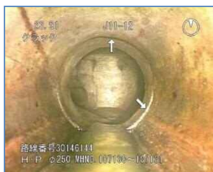
既設管渠の状況(カメラ調査結果)
