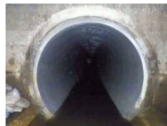
更生工法による更新（更新後）
