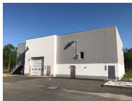
沼ノ端中継ポンプ場
