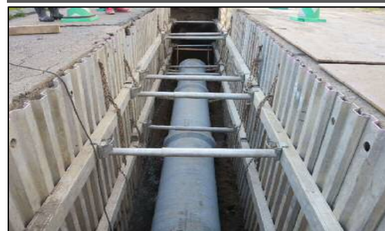
雨水管渠整備
