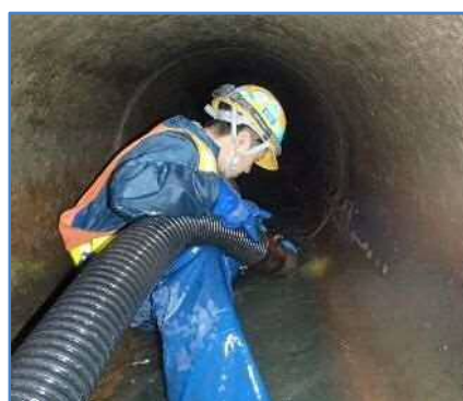
管渠清掃作業の様子（管内）
