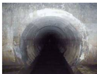
老朽管の状況（更新前）
