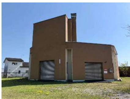
錦岡中継ポンプ場
