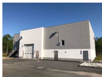
沼ノ端中継ポンプ場
