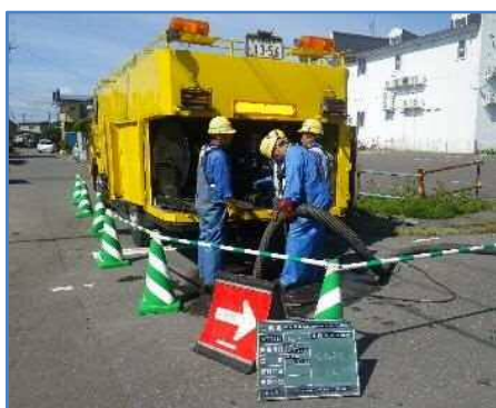
管渠清掃作業の様子
