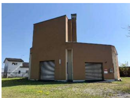
錦岡中継ポンプ場
