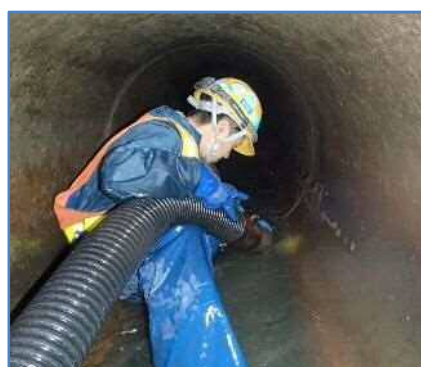
管渠清掃作業の様子（管内）
