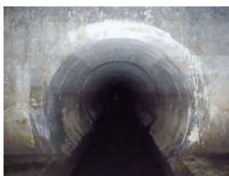
老朽管の状況（更新前）
