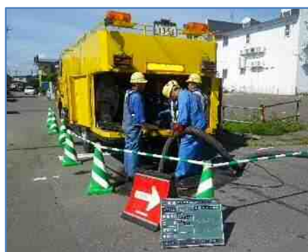
管渠清掃作業の様子
