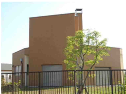
錦岡中継ポンプ場
