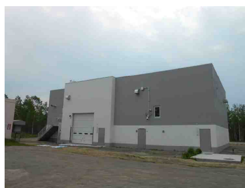
沼ノ端中継ポンプ場
