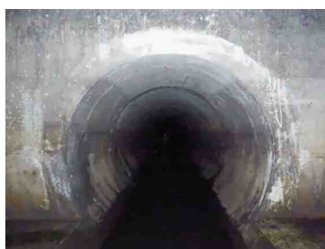
老朽管の状況(更新前)
