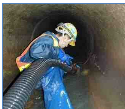
管渠清掃作業の様子(管内)
