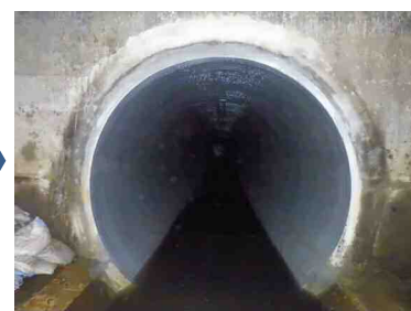
更生工法による更新(更新後)
