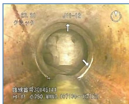
既設管渠の状況(カメラ調査結果)
