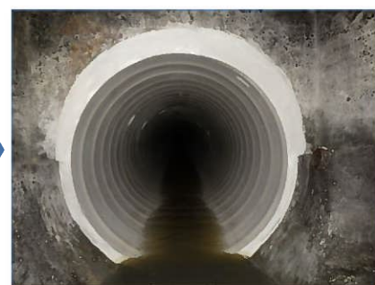
更生工法による更新(更新後)
