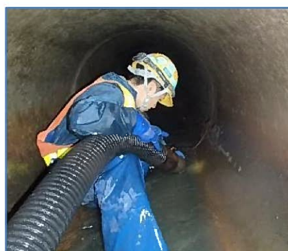
管渠清掃作業の様子(管内)
