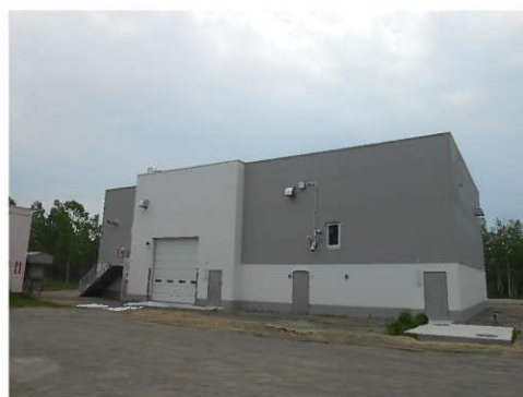
沼ノ端中継ポンプ場
