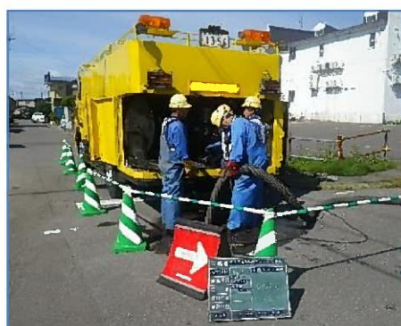
管渠清掃作業の様子
