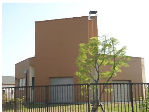
錦岡中継ポンプ場
