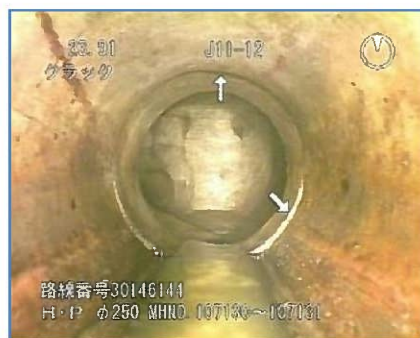
既設管渠の状況(カメラ調査結果)
