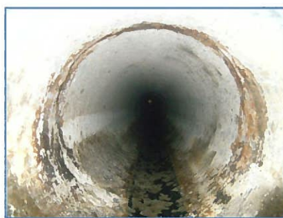
老朽管の状況(更新前)
