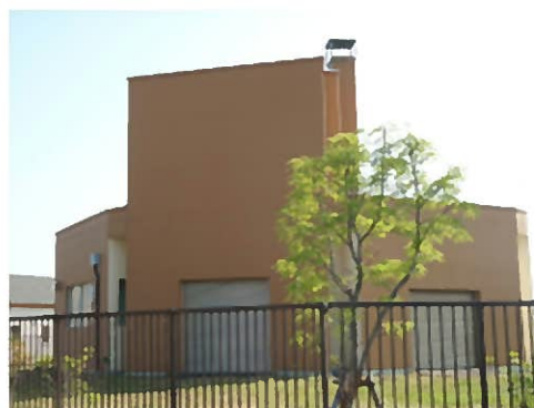
錦岡中継ポンプ場
