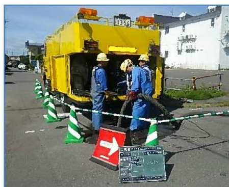
管渠清掃作業の様子
