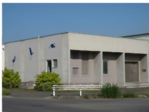
明野中継ポンプ場
