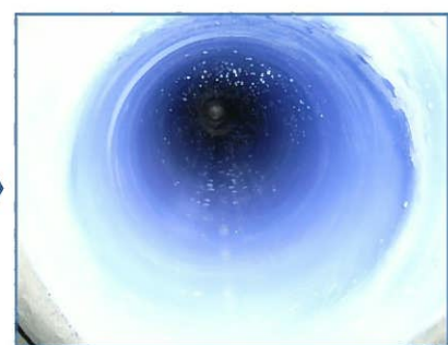
更生工法による更新(更新後)
