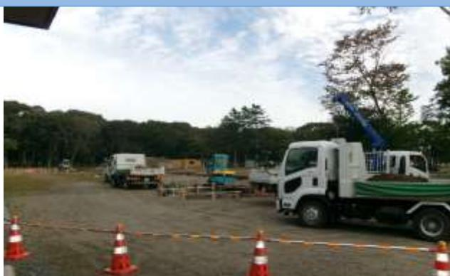
外構工事が始まり約1か月。現在、駐車場やバスの停まるロータリーの工事が行われています。写真は雨水管設置の工事をしているところです。着々と工事が進んでいるようです。
