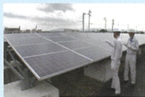
太陽光発電設備の検査の様子
