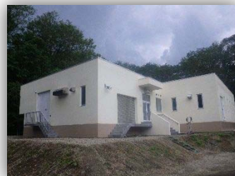
写真 6-3 勇振ポンプ場の耐震化
