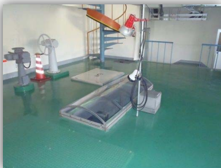
写真 3-3 管理棟下の滅菌井
