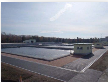
写真 2-1 耐震化が完了した 4～6 号緩速ろ過池
