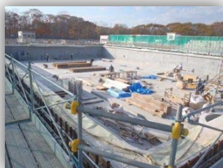
写真 6-2 緩速ろ過池の耐震化
