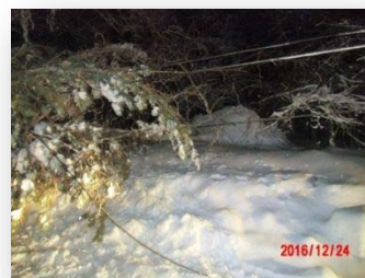
写真 3-12 倒木による断線
