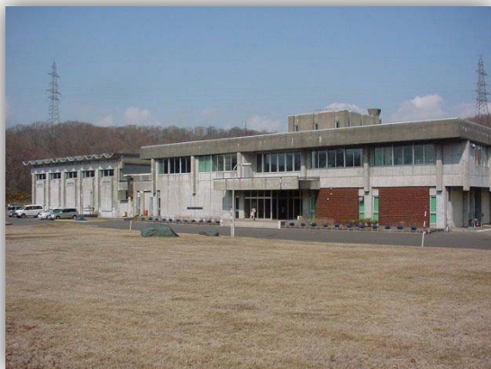
写真 2-2 錦多峰浄水場
