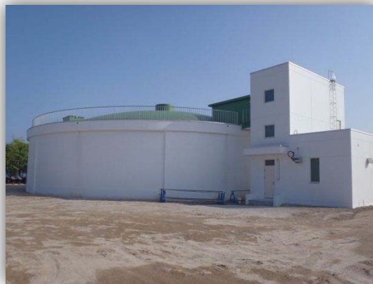
写真 2-3 錦多峰第3配水池
