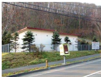
写真 3-8 市内のポンプ場
