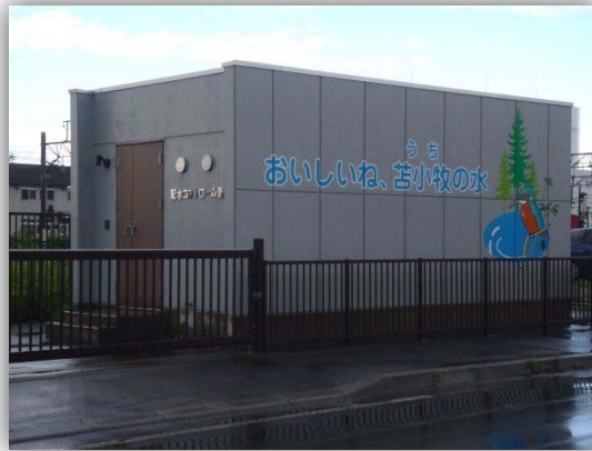
写真 2-4 配水コントロール施設
