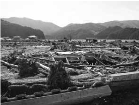
▲被災後の宮城県石巻市の様子（平成22年3月28日）
