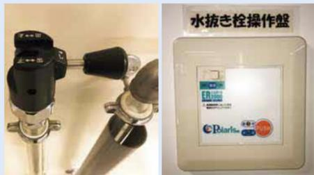
水抜栓 電動水抜装置
