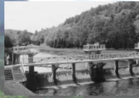
勇振取水場 日量 40,000m 3 の取水能力があります
