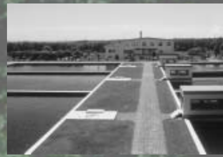
ろ過池 6つの池があり、1日平均4~6mの速さでゆっくりろ過されます
