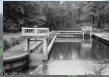
幌内取水場 日量 8,100m 3 の取水能力があります
