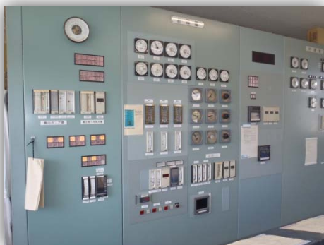
写真 3-1 老朽化した中央監視装置
