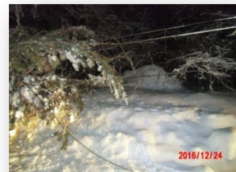
写真 3-12 倒木による断線
