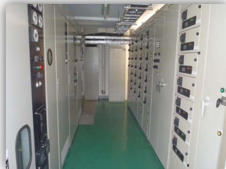
写真 3-2 狭隘化した電気室
