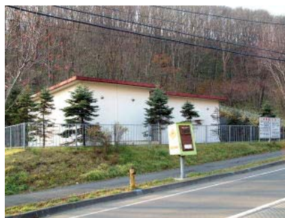
写真 3-8 市内のポンプ場
