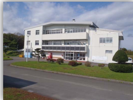
写真 3-4 老朽化が進む管理棟
