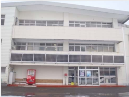
写真 3-5 設置した太陽光パネル
