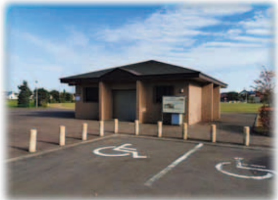
▲防災備蓄庫を備えた公園（日の出公園）
