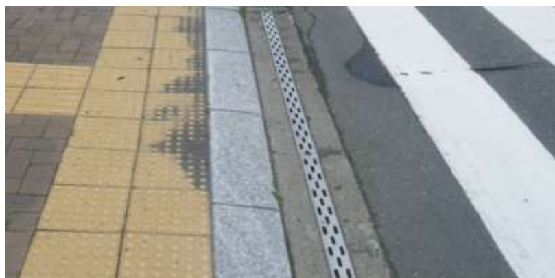
横断歩道への誘導ブロックとグレーチング（排水柵）の設置状況
