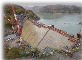
新桂沢ダム(嵩上工事)
