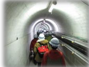
滝里ダム(監査廊)
