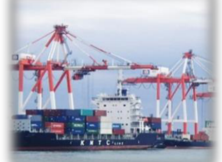
苫小牧港(東港区)
