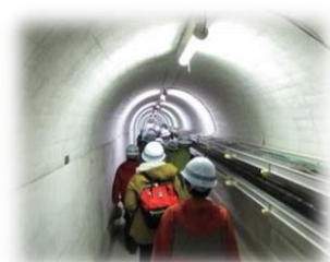
滝里ダム (監査廊)
