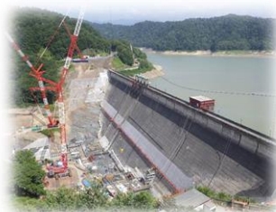
新桂沢ダム(嵩上工事)
