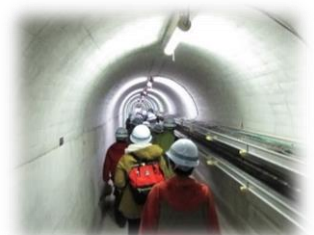
滝里ダム(監査廊)
