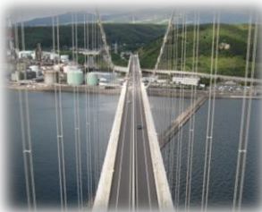
〈白鳥大橋主塔から〉
