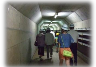
〈滝里ダム監査廊見学〉
