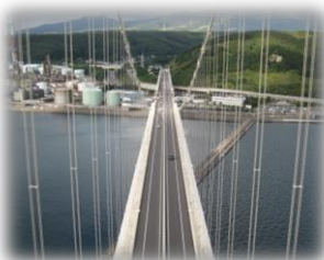
〈白鳥大橋主塔から〉
