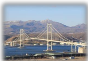
〈白鳥大橋全景〉
