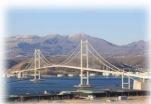
〈白鳥大橋全景〉
