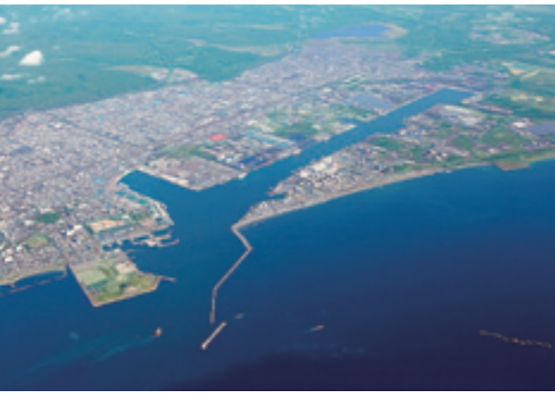
苫小牧港西港区
