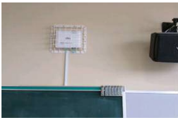
【教室内機器設置】
