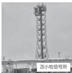
苫小牧港は、人工掘り込み式の地形であることや、大型のRORO船やフェリーが多数運航していることから、2カ所に信号を設置しています（苫小牧信号所と勇払信号所）。信号では、「入航してよい」をI（イン）、「出航してよい」をO（アウト）などで表示し、スムーズな運航を守っています。
