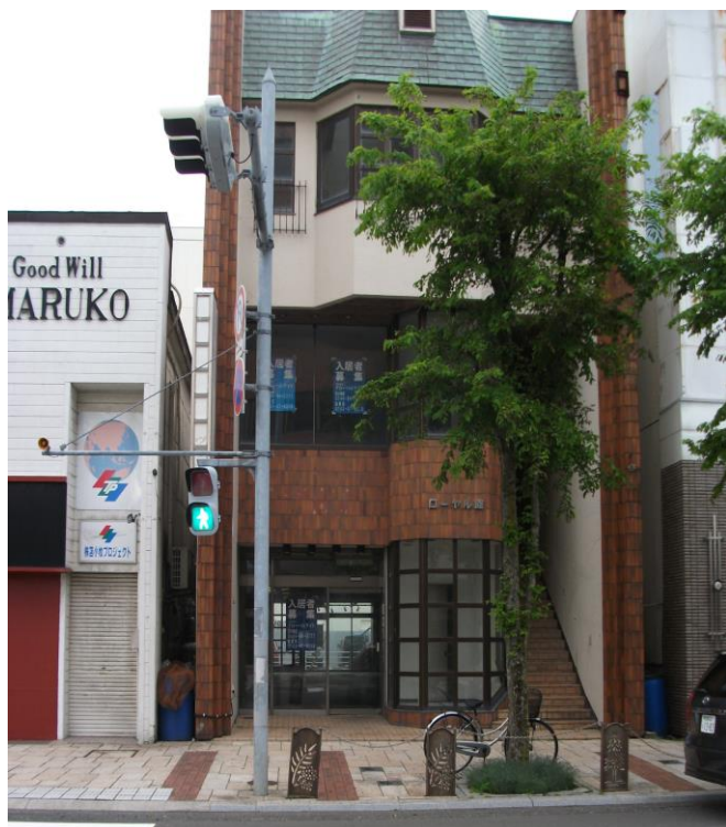
↑ 駅前本通側 外観
