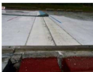
ハイランドスポーツセンター 屋外スケートリンクの劣化
