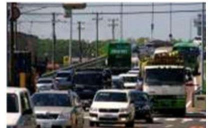
国道 276 号 緑跨線橋
