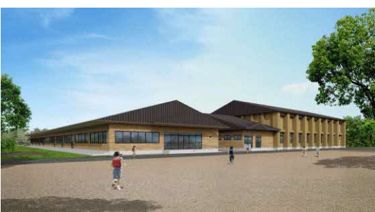
新校舎令和6年7月完成予定
