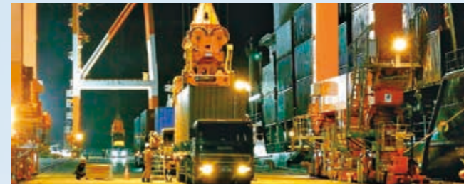
苫小牧国際コンテナターミナル
