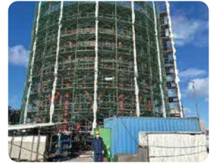
建設中のCO 2 受入設備(タンク)
