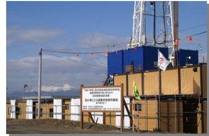
苫小牧CCS調査井作業場
