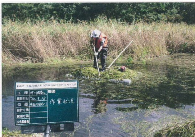
【作業状況①】
