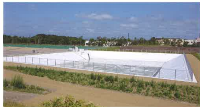
浸出水調整池
