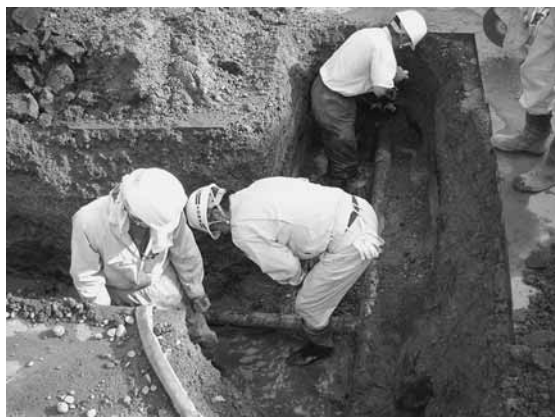
漏水復旧工事のようす
