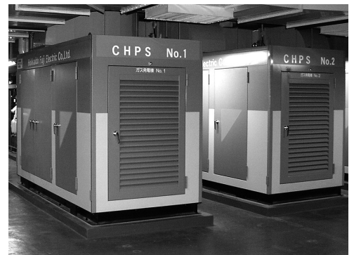
ガス発電設備外観
