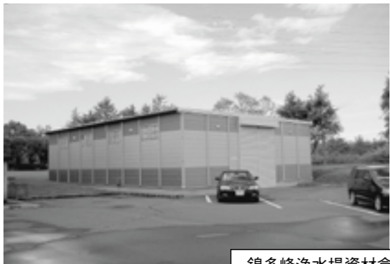
錦多峰浄水場資材倉庫
