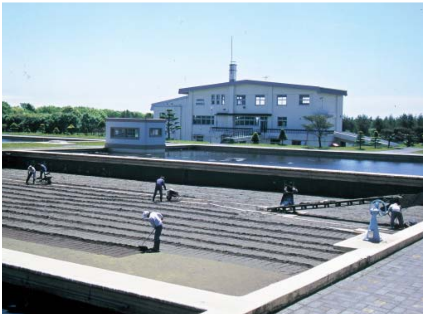
汚砂揚げ（汚れた砂面を削り取る）風景
