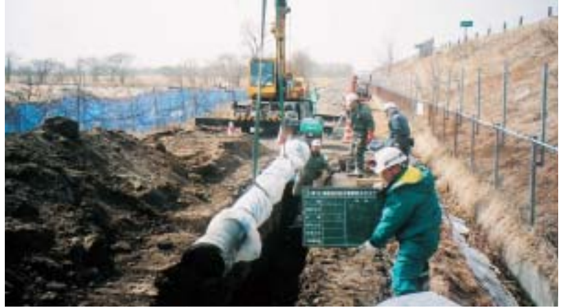
配水管布設工事の現場
