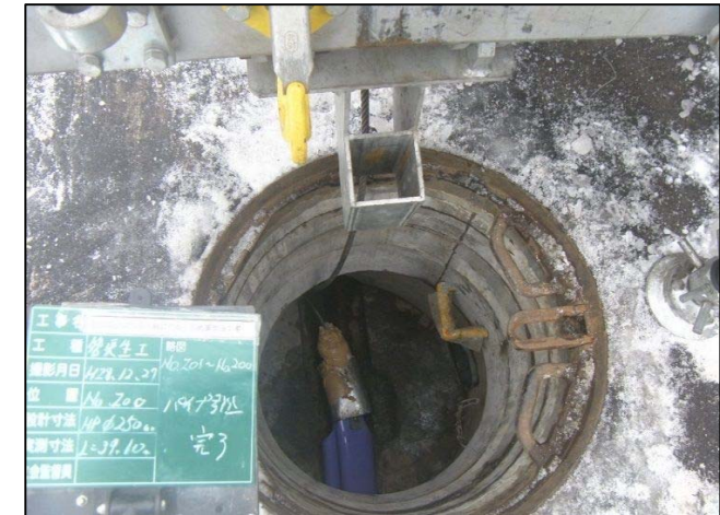
材料引込み完了
