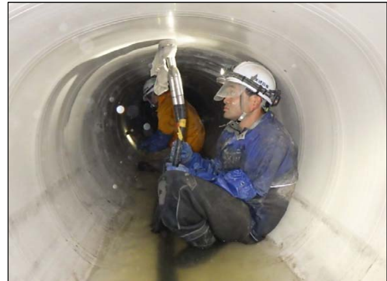
充填材注入状況（管内部）
