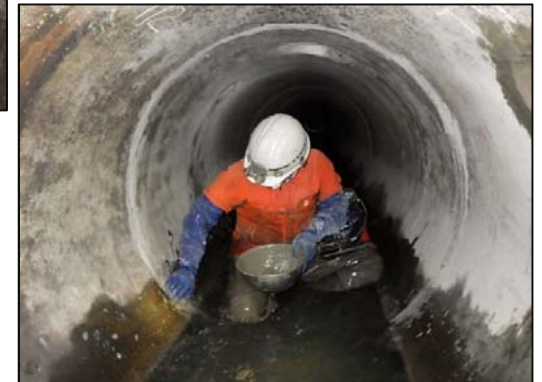
既設管補修状況
