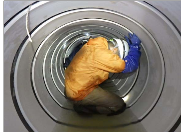
製管材仮置き状況
