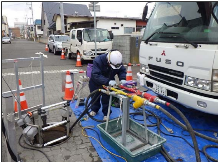
充填材注入状況（地上部）
