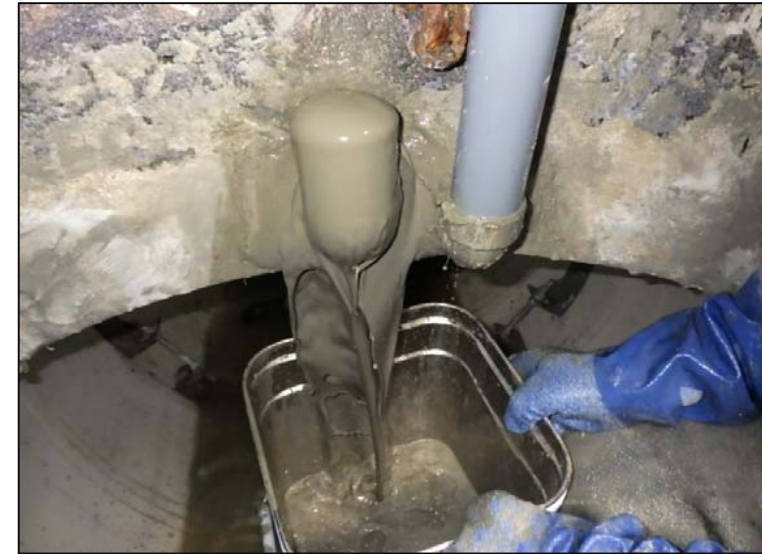
充填完了確認（オーバーフロー状況）
