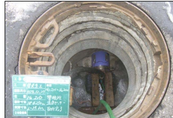
蒸気加熱状況
