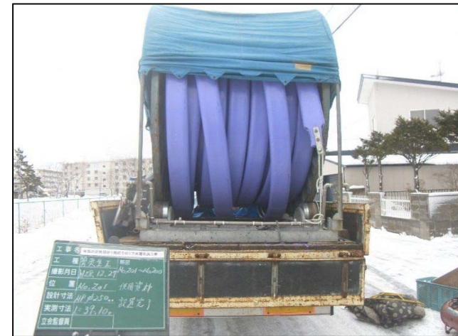
材料設置状況
