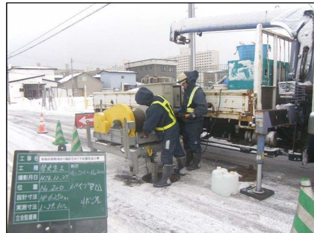
材料引込み状況 (ウインチ使用)
