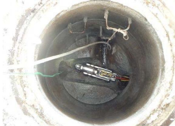
②新設する管の支障になる箇所である、取付管開口部を穿孔機で削り取ります。
