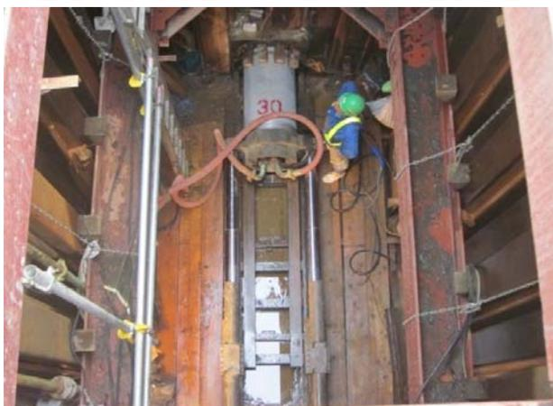
④管を全て地中に押し切った後、マンホールを設置して埋戻します。
