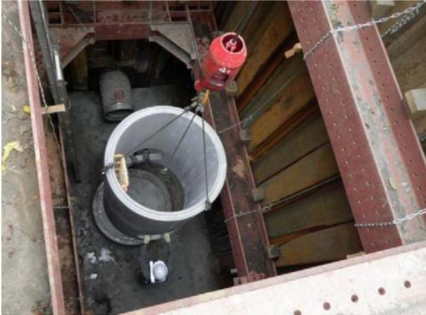
⑤最後に、鋼矢板を引き抜き、舗装を復旧して完成です。
