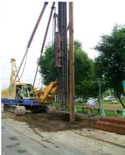
②打設した鋼矢板の中をバックホウ等で掘削していきます。
