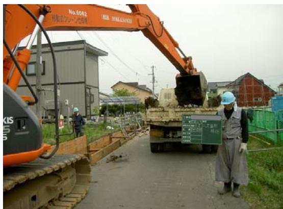
③掘削した床面に基礎を形成し、高さを通りを調整しながら管を敷設していきます。
