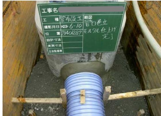
⑤汚水管敷設の場合、住宅ごとに公設柵を設置して下水道本管に接続します。
