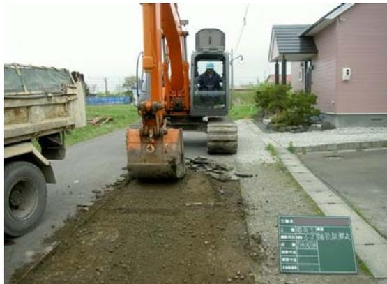
②土留めをしながら管を埋設する深さまでバックホウで掘削します。
