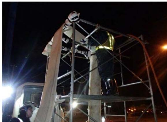
④更生材料を管内に挿入後、温水を循環させ、硬化させていきます。
