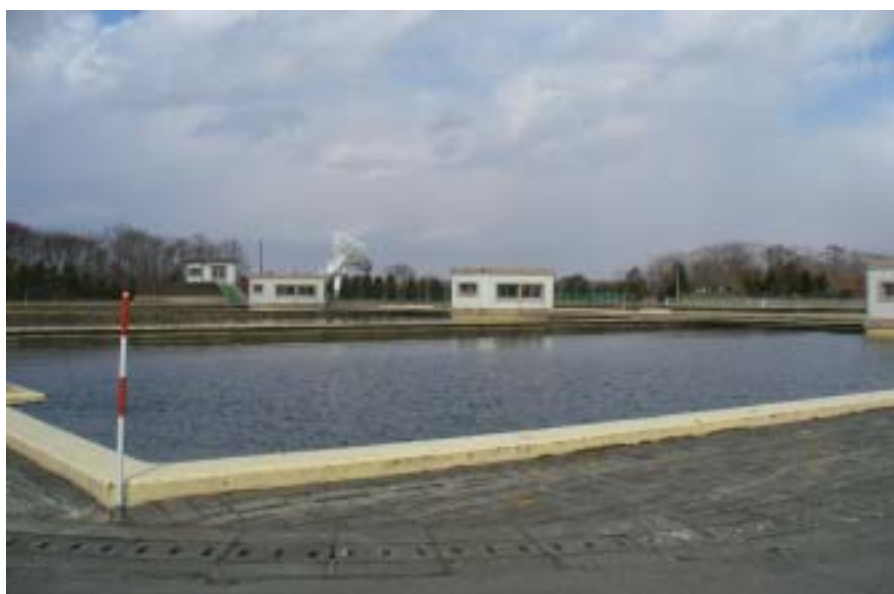
高丘浄水場 ろ過池
