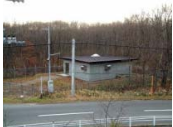
植苗配水中継ポンプ場
