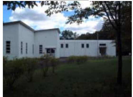
幌内ポンプ場・地下水取水場
