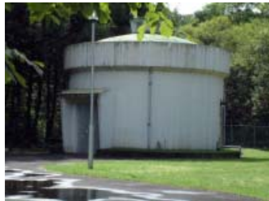
高丘地下水取水場
