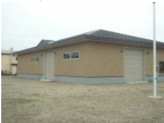
日の出公園緊急災害対策用水道機材貯蔵庫
