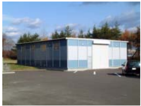
錦多峰緊急災害対策用水道機材貯蔵庫
