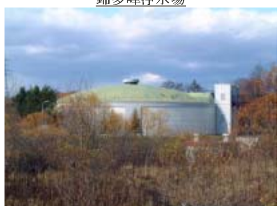
錦多峰第2配水池
