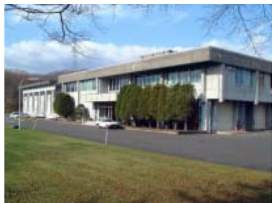
錦多峰浄水場
