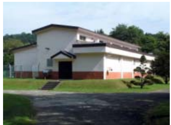
勇振ポンプ場
