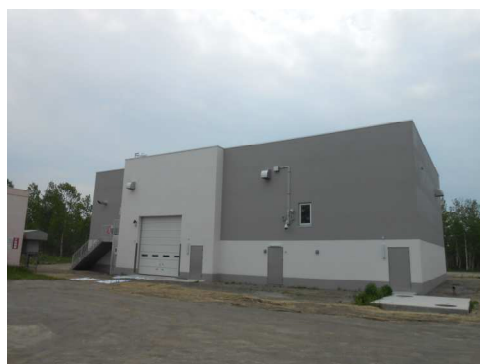
沼ノ端中継ポンプ場
