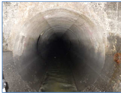
老朽管の状況(更新前)
