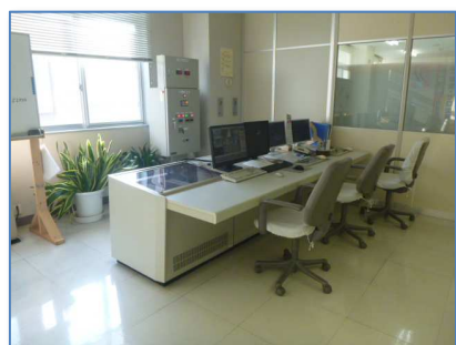
中央監視 (更新前)
