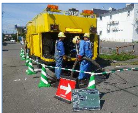
管渠清掃作業の様子
