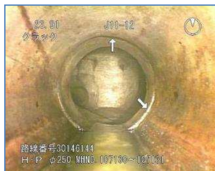
既設管渠の状況(カメラ調査結果)
