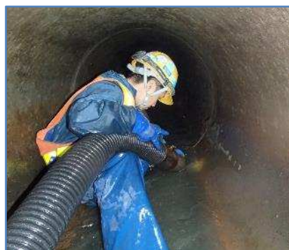
管渠清掃作業の様子(管内)
