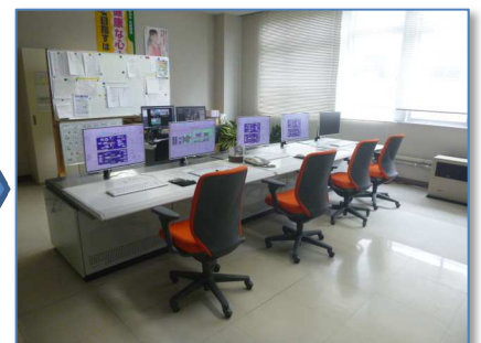
中央監視 (更新後)
