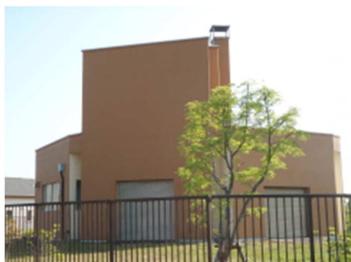
錦岡中継ポンプ場
