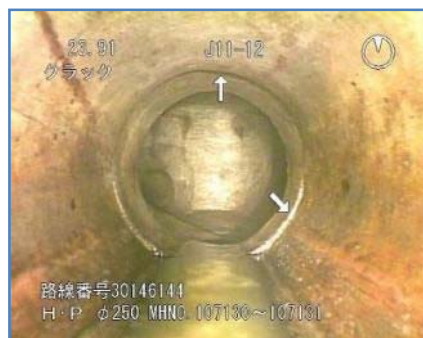
既設管渠の状況(カメラ調査結果)
