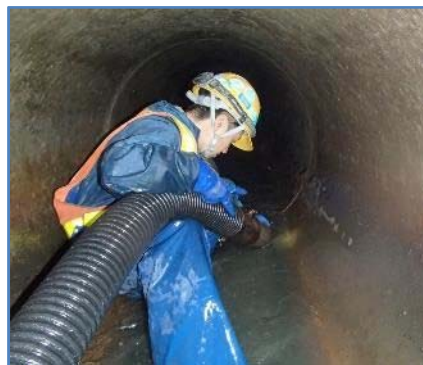
管渠清掃作業の様子（管内）
