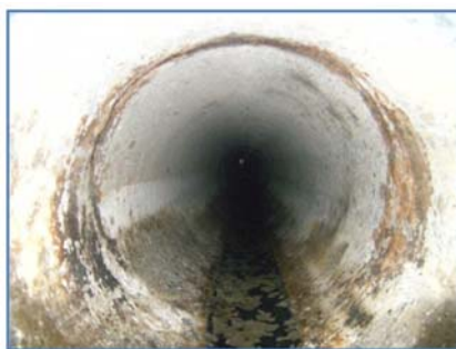
老朽管の状況(更新前)
