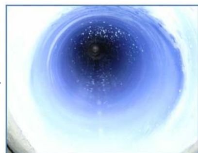
更生工法による更新(更新後)
