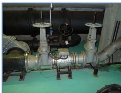
電磁流量計(更新前)
