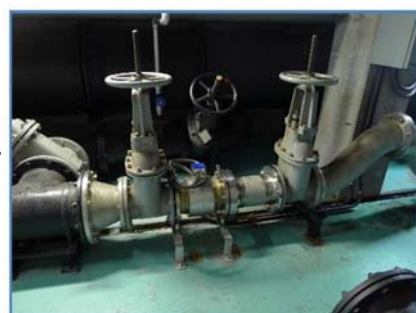
電磁流量計(更新後)
